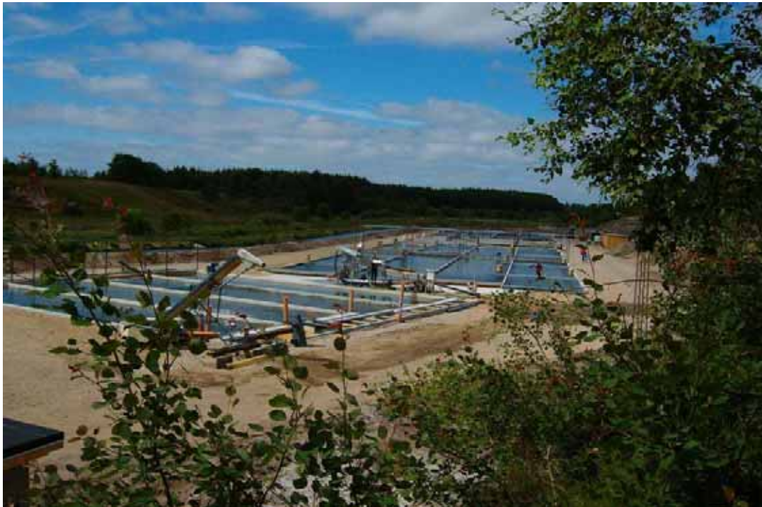
Figur 2.2 Et modeldambrug med raceway bassiner af beton og mekanisk og biologisk rensning Foto: Per Bovbjerg Pedersen, DFU
