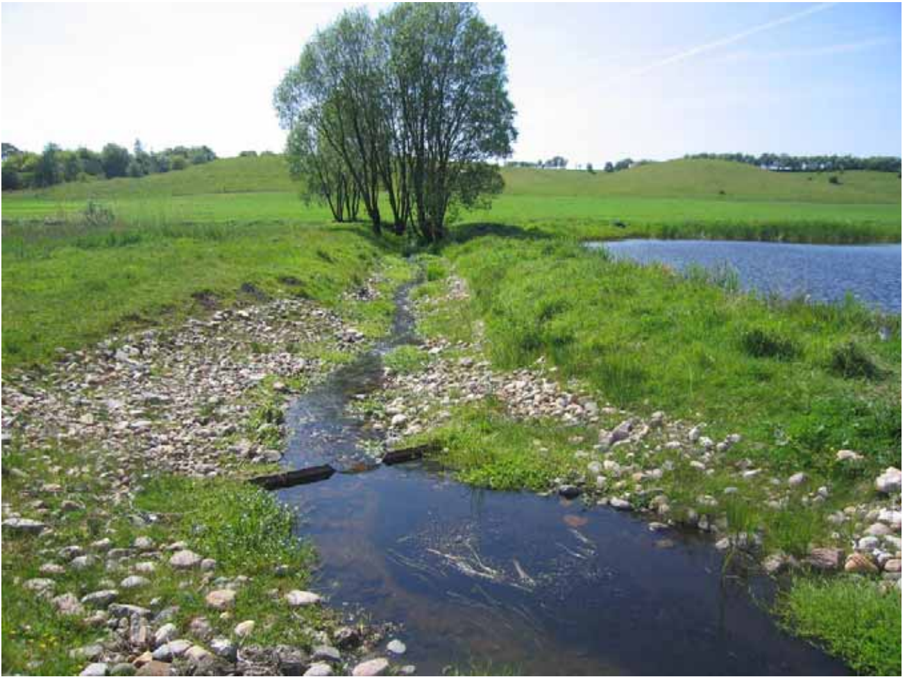
Figur 6.1 Omløbsstryg ved Skravad Mølle Dambrug. Foto: Alfred Jokumsen, DFU
